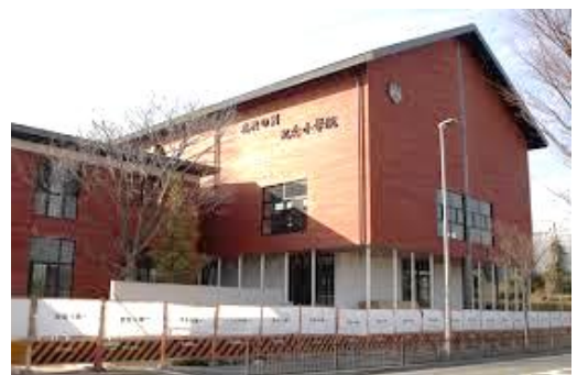
建設中の「瑞穂の国記念小学院」の校舎
