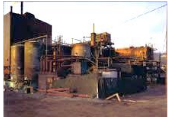
荒れ果てた工場。かつて繁栄していた工業地帯が1970年代後半には、ラストベルト(さびついた工業地帯)に変貌した
